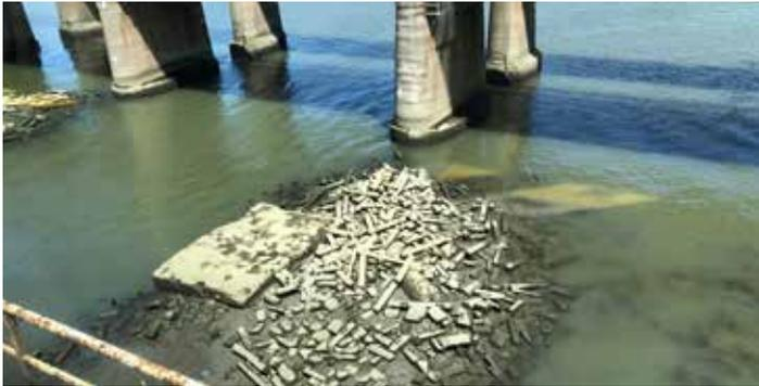
▲今も相模川に残る、大正関東地震で倒壊した馬入橋橋梁の残骸。
