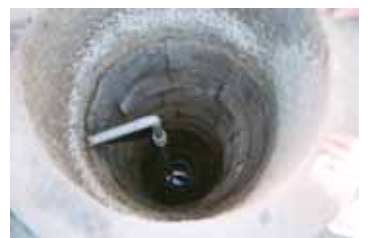
井戸の内部 西真土
