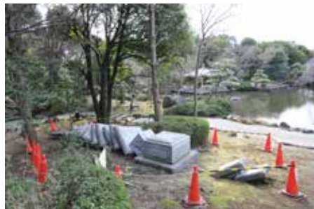
平成23年(2011)3月 東日本大震災の被害 総合公園の転倒した多層塔。
