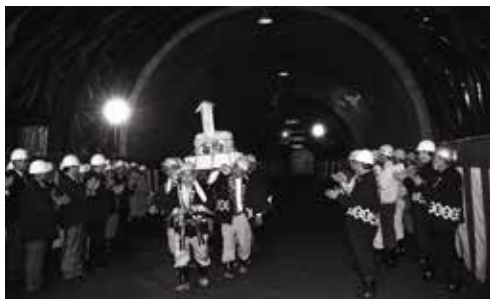
平成8年(1996)5月 日向岡トンネル完通式 完通を祝う日本酒樽が担がれてトンネルの中を練り歩いた。
