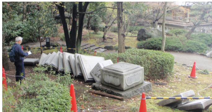
市内でも様々な被害があり、総合公園では石塔が倒壊した
