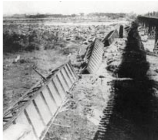
大正12年関東地震による馬入川鉄橋の落下。液状化によるものと考えられる。
