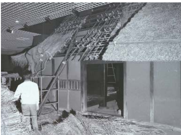
↑開館に向け、古民家(現在1階に展示されている相模の家)の屋根に茅を葺く作業中(1976年3月)。
