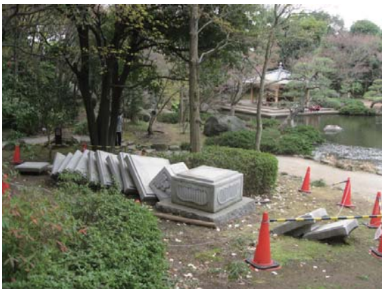
総合公園日本庭園内の石塔の倒壊
